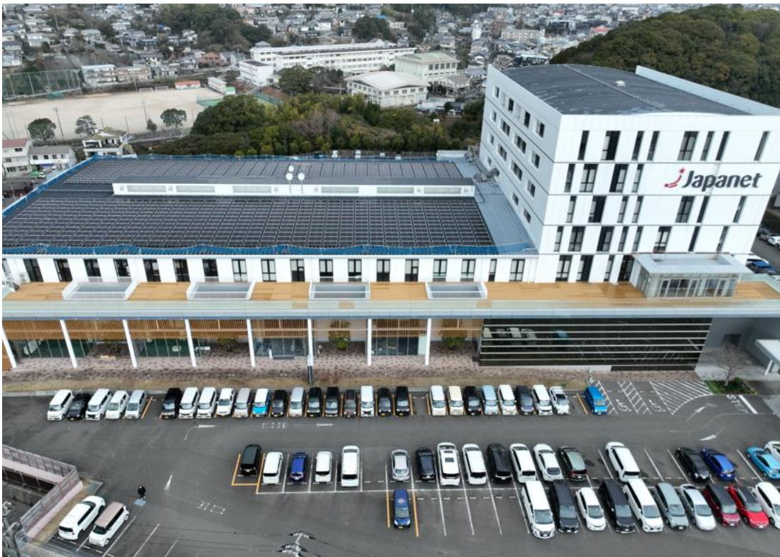
※ジャパネットたかた 本社 屋根上太陽光パネル
