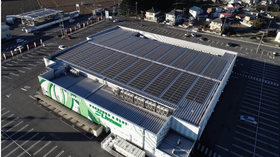
※ライブガーデン栃木本店、屋根上太陽光パネル
